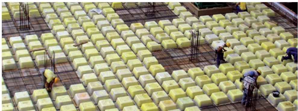
Encofrado RECUB en el aeropuerto de Palma de Mallorca, España
