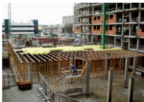
Montaje del encofrado RECUB desde torre móvil
