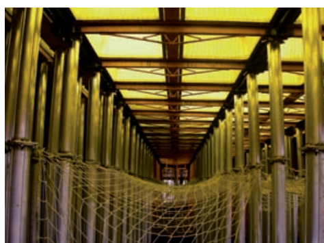
Montaje del encofrado RECUB con Redes bajo forjado
