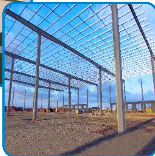
APLICAÇÃO EM OBRA
