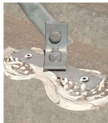
A colagem do suporte Tel 978 em telhas metálicas deve ser feita com adesivo Tel 5907
