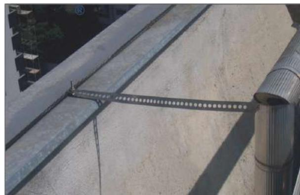
A fita Tel 751 é adequada para equipotencialização de estruturas externas à edificação, dentro do volume protegido pelo sistema de captação
