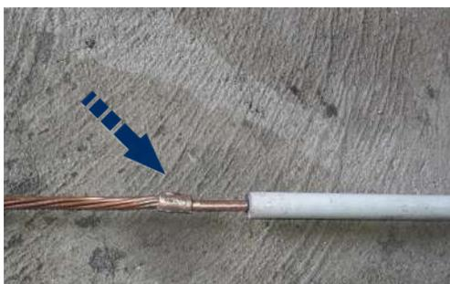
A continuidade elétrica do Condutor CUI para o aterramento pode ser feita na horizontal, com solda exotérmica tipo CCH e cabo de Cobre nu 50mm², antes de sua fixação na posição vertical.
