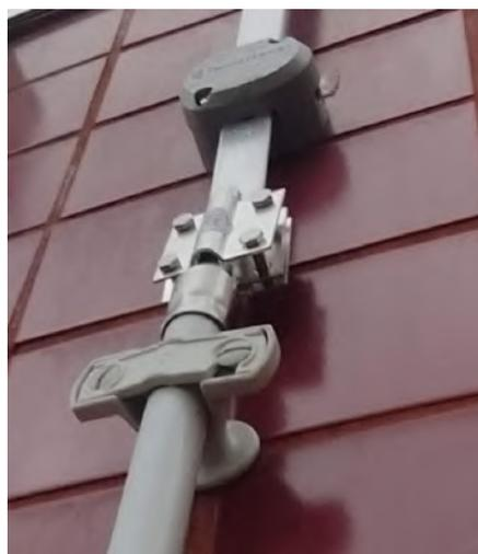
Detalhe da transição entre descida de barra chata e condutor CUI com conector Tel 722
