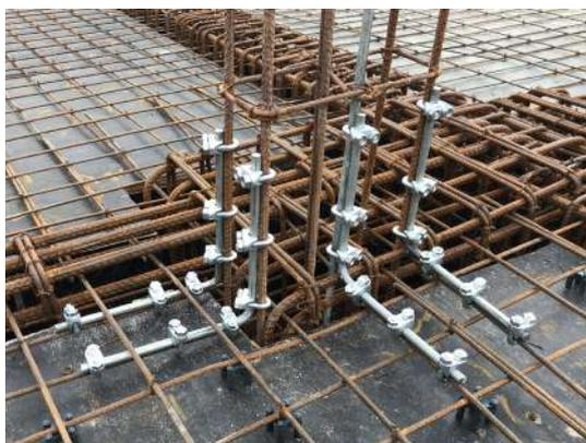
O item 4.3 da NBR 5419/2015-3 recomenda que pelo menos 50% das ferragens verticais dos pilares sejam conectadas com as ferragens horizontais de lajes ou vigas. O uso das emendas L Tel 767 facilita a inspeção visual e a documentação fotográfica destas conexões antes da concretagem. É imprescindível o ensaio de continuidade elétrica das ferragens conforme anexo da norma.
