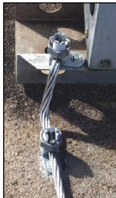
Conexão em estruturas metálicas
